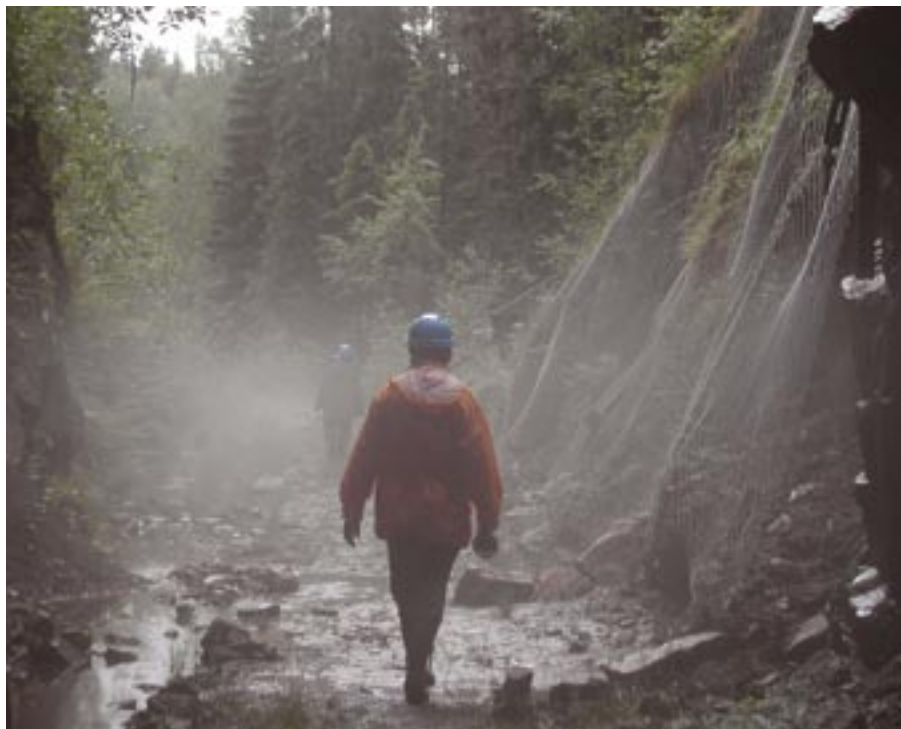
Besökare på väg ut från den 137 meter långa Nya Bastnässtollen med Knuts schakt längst in, där dagsljuset strilar ned i bergrummet vilket ger en magisk upplevelse. Stollen måste skrotas med jämna mellanrum för att vara tillgänglig för besök. Skrotning planeras ske våren 2008.
