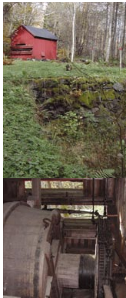
Det unika hakspelet från 1873 på Bastnäsfältet. Pinnar visar stånggångens riktning.
